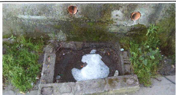
Foto 9: Reparación de red de drenaje que se encuentra a la interperie frente al módulo 2
