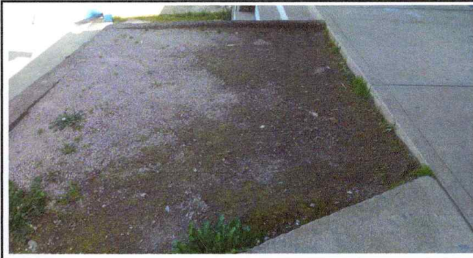
Foto 8: Mejoramiento de area verde, levantado de pared con hileras de bloques en muro de contención
