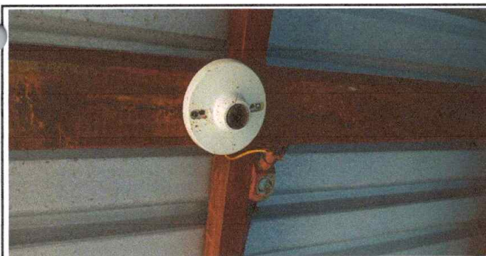
Foto 5: Mejoramiento de sistema eléctrico, cambio de plafoneras en mal estado e instalación de 4 bombillas eléctricas con estructura de metal para protección
