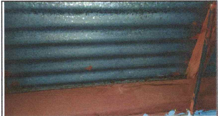
Foto 2: Cambio de lámina acanalada en mal estado por lámina troquelada calibre 26
