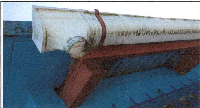
Foto 12: Instalación de tubos fundidos en concreto bajadas de agua de lluvia.
