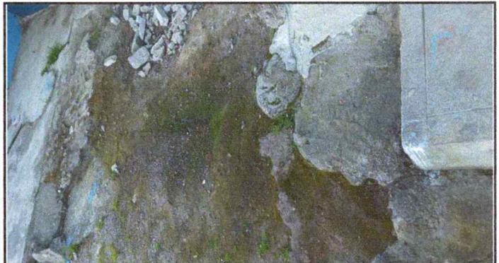
Foto 4: Mejoramiento de piso en mal estado por jardinización, fundición de piso y pequeños arreates
