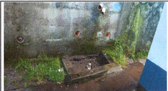
Foto 10: Reparación de red de drenaje que se encuentra a la interperie frente al módulo 2
