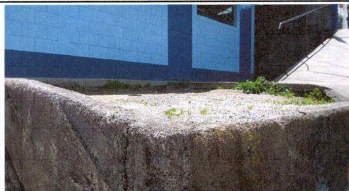
Foto 7: Mejoramiento de area verde, levantado de pared con hileras de bloques en muro de contención
